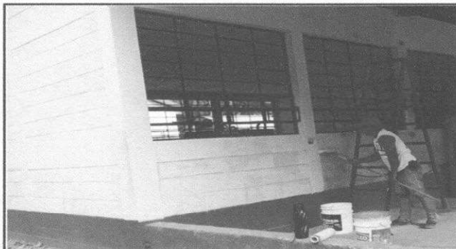
Foto 2: se observa las sustitucion de la pintura en las paredes en el modulo 1
