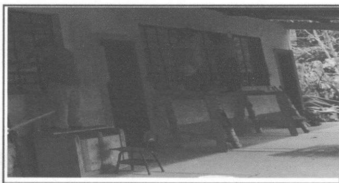
Foto 5: se observa sustitucion de vidrios del modulo 1
