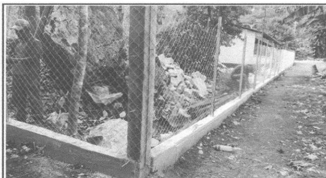
Foto 4: se observa la sustitucion del muro perimetral en el predio del establecimiento
